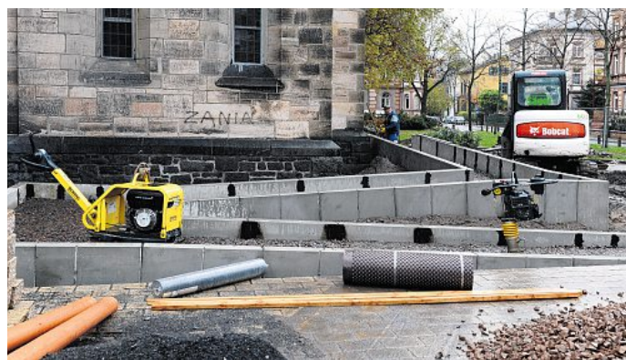
Zugang ohne Stufen: An der Johanneskirche wird die seit langem gewünschte Rampe gebaut. FOTO: CLAUD VÖLKER
